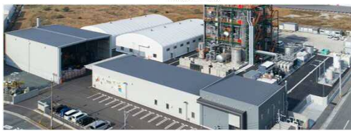
再生ポリエステル製造事業プラント (若松区響灘地区)
