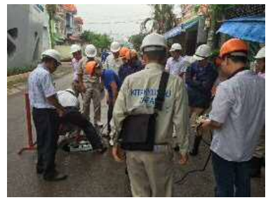
市内企業が開発した管渠検査ロボット “もぐりんご”活用の様子 (ベトナム)
