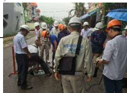
管渠検査ロボット “もぐりんこ” 活用の様子 (ベトナム)
